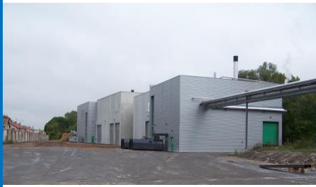
Credits : Everbal, Chaufferies biomasse sur le site d'Evergicourt
